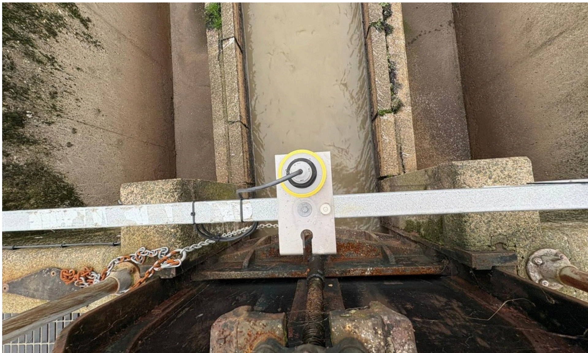
Radar VEGAPULS C 21 para medición de nivel y caudal en canal
