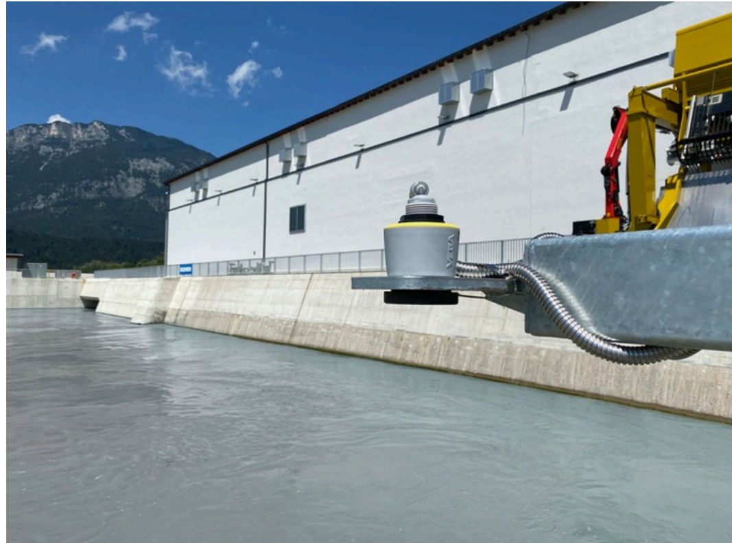
Medición de nivel en una balsa de grandes dimensiones
